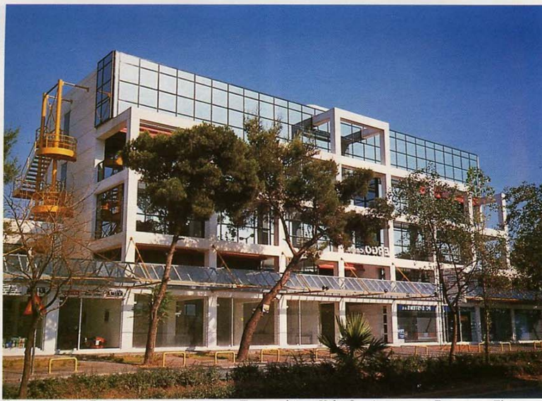
Κτίριο γραφείων / Εμπορικό κτίριο, στη Λεωφόρο Παπανικολή στο Χαλχάλανδρο. Αρχιτέκτονες Γιώργος και Ελένη Μανιέτα. Εδώ πρόκειται για το επιτυχημένο αποτέλεσμα, εναρμονισμού πολλαπλών συστημάτων, αποσύνθεσης και ανασύνθεσης στοιχείων του κλασικού φέροντος οργανισμού με τον αγμέ του λεκανοπεδίου, με διαθέσιμες κολά υλικών και χρώματος (σιγήματα).
