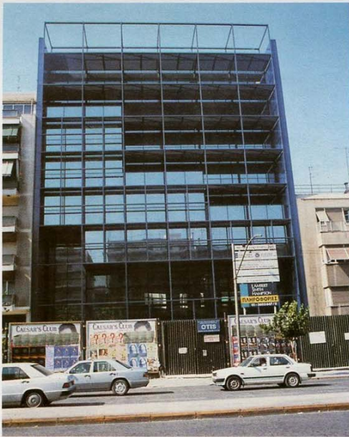
Κτίριο γραφείων ΓΕΚ Ψυτικής, στη Λεωφόρο Αλεξάνδρας. Αρχιτέκτον Αλεξάνδρος Τομπάζης και συνεργάτες. Προσπάθεια με έκδηλες προθέσεις αντιμετώπισης της όψης σαν ένα ανεξάρτητο συνθετικό πλαίσιο λειτουργίας (έναν "τοιχό που αναπνέει - ευέλικτη όψη"), που υπακούει στους νόμους των αναλογιών, με νέα υλικά και τολμηρό (για τα καθ' ημάς), αλλά ευπρόσδεκτο, χρώμα.
