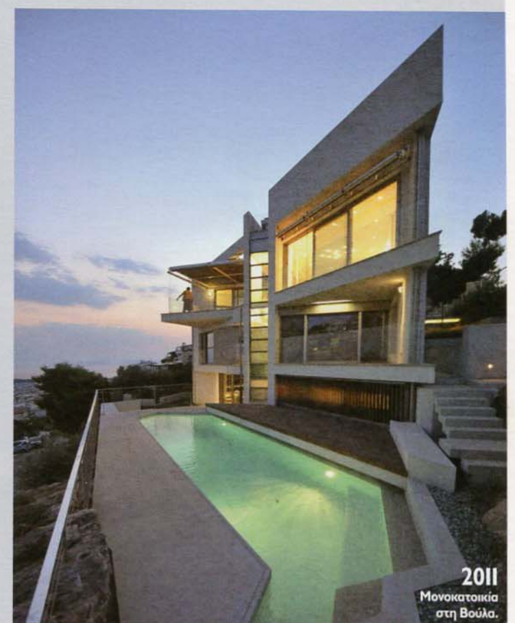
2007 Δύο κατοικίες στην Εκάλη.
